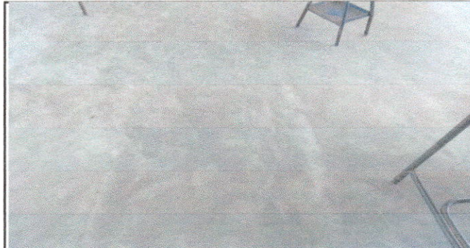
Foto 4: Piso de concreto
