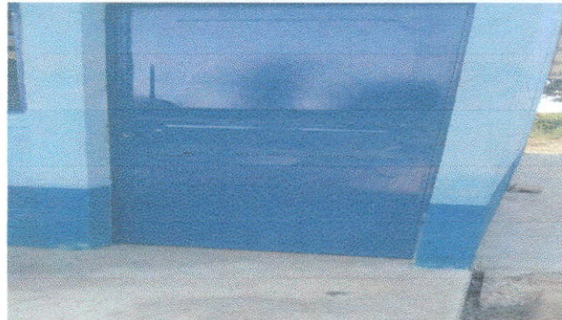
Foto 2: Puerta Instalada con chapa YALE
