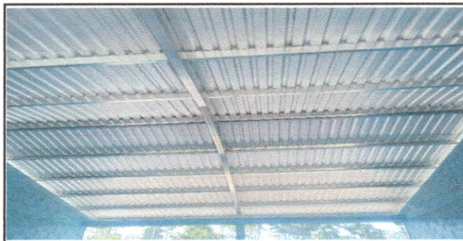
Foto 6: Estructura de techo instalada
